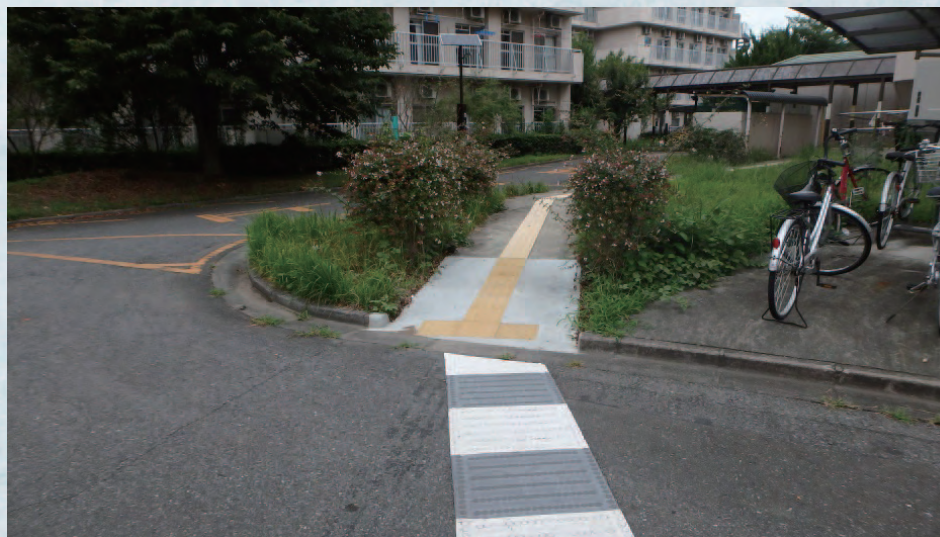
歩車道の段差解消
