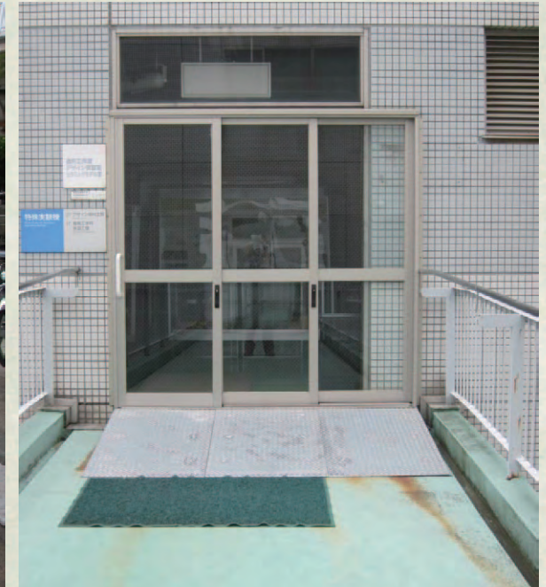
▲特殊実験棟2階の出入り口に段差があったため、スロープを設置
