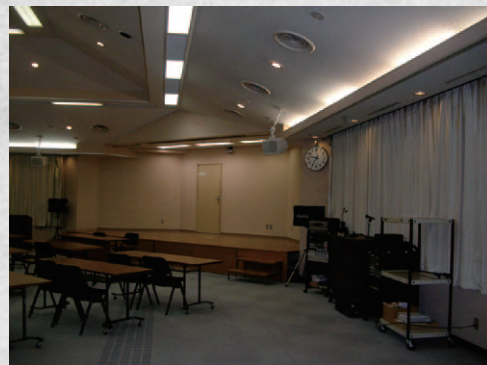
▲春日・講堂天井改修（改修前）
