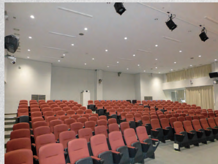
▲天久保・講堂天井改修（改修後）
