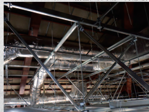
▲つり天井のブレース補強
