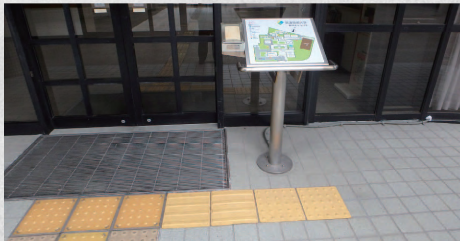
▲春日・校舎等エントランスの案内板前の点字ブロックを延長敷設
