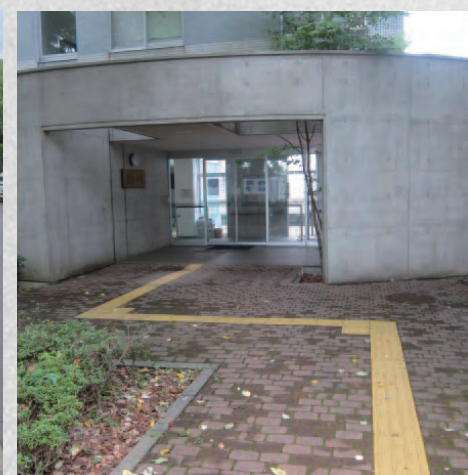
▲天久保・支援棟入口を見る
