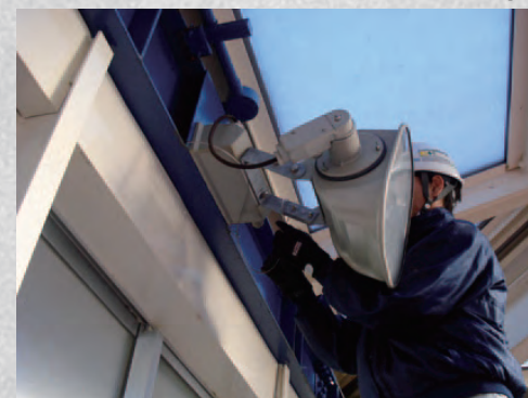
▲照明の落下防止
